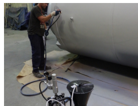
Depósito de gravedad
