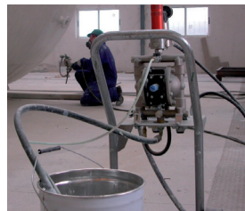
Sonda di assorbimento (Suzione)
